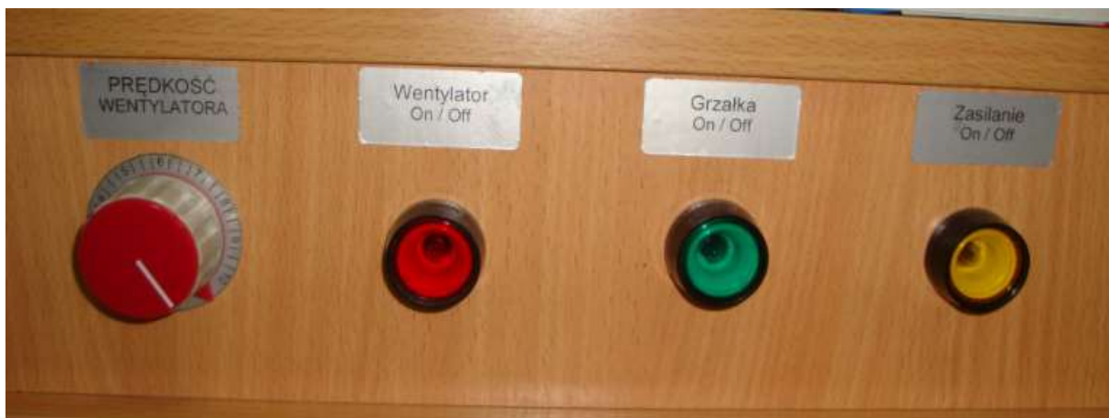
Rys.9. Panel sterowania stanowiska pomiarowego
